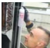
J'utilise le produit détecteur de fuites gazeuses en aérosol pour localiser précisément les fuites de fluide frigorigène. Les détecteurs électroniques ne permettent qu'une localisation grossière. L'avantage d'IBIOTEC DÉTECT 1000 est que la pression reste disponible, même si l'aérosol est resté dans une température ambiante basse. Le détecteur de fuites que j'utilisais avant avait du mal à sortir de l'aérosol lorsqu'il faisait froid, et il y avait très peu de bulles.
